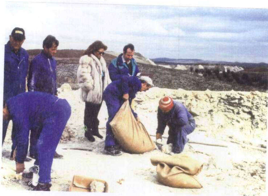
Foto 5. Operación de carga del explosivo
